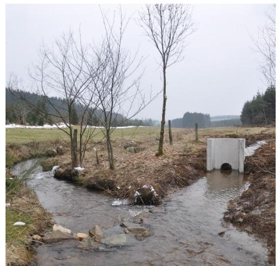
En 2013, un budget a été alloué pour rendre fonctionnel le canal d'abissage, ancienne pratique agropastorale. Les ligneux ont été supprimés et le canal a été réouvert. Un tuyau a été placé à l'entrée du canal. Trois barrages ont été installés pour apporter l'eau progressivement à une partie puis à l'autre.
